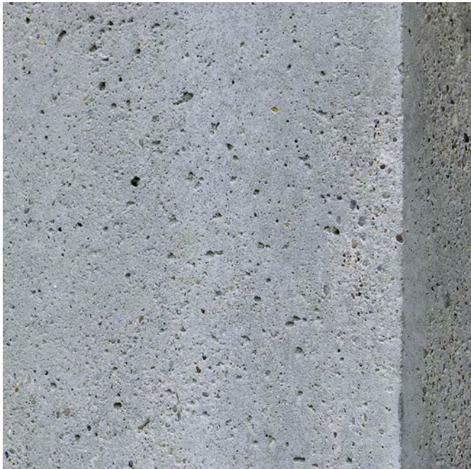
Bild 9: Sandgestrahlte Betonoberfläche
