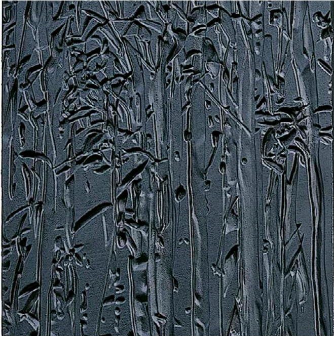
Bild 5: Betonoberfläche mit Gummi-Matritze texturiert und schwarz gestrichen – Universitätsbibliothek in Utrecht, 2004, Architekt: Wiel Arets, Maastricht
