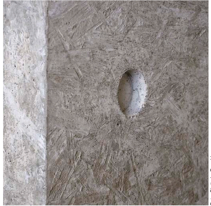
Bild 6: Mit OSB-Platten geschaltete Oberfläche mit Kante
