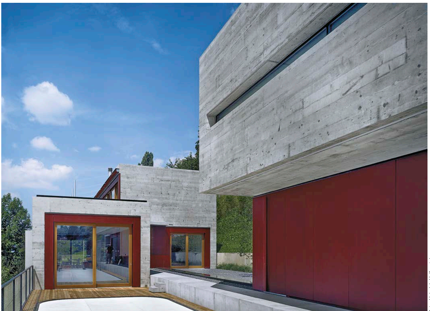
Bild 4: Wohnhäuser in Herrliberg am Zürichsee, 2005, Architekten: Burkhalter Sumi, Zürich
