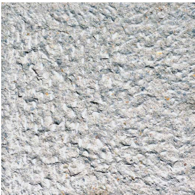
Bild 10: Gestockte Betonoberfläche
